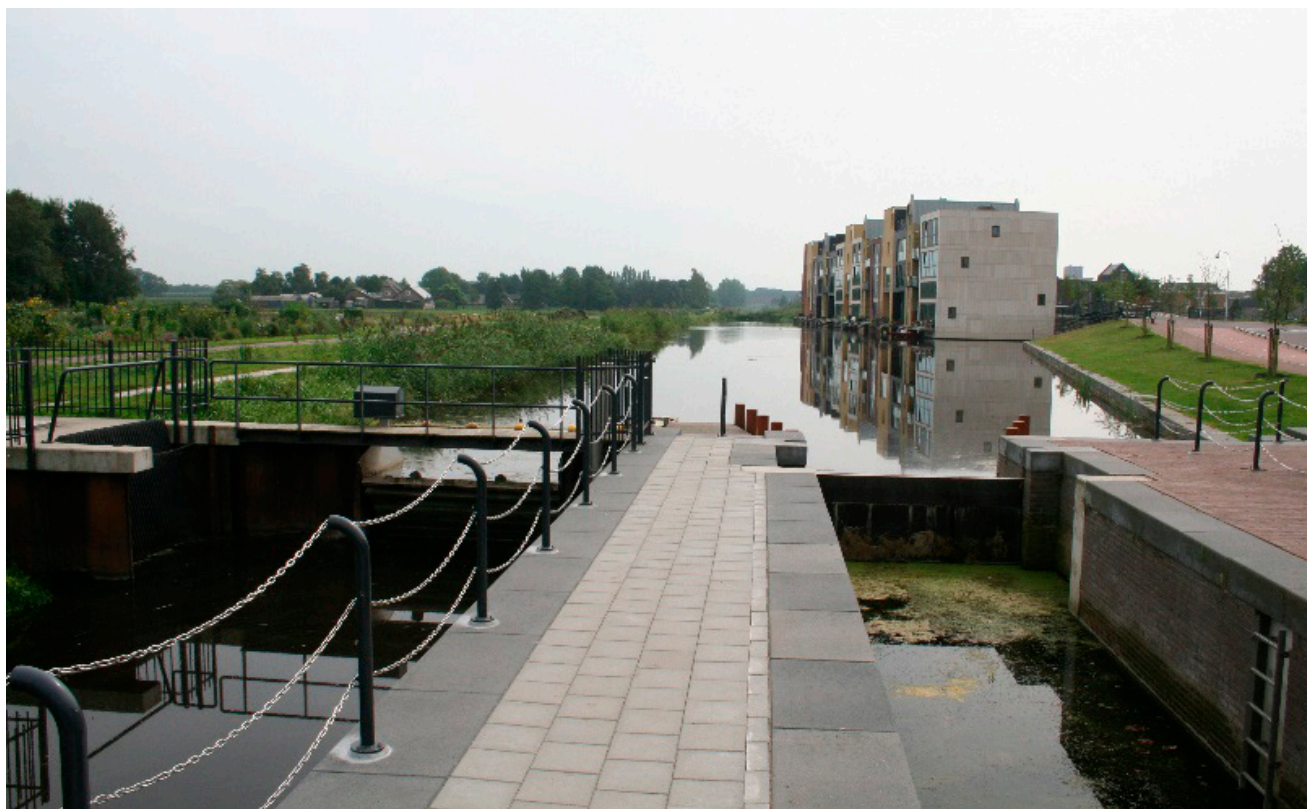
Figuur 2 Voorbeeld van een bestaand aquathermieproject in Vathorst. De warmte uit het oppervlaktewater wordt 's zomers opgeslagen in de bodem.
