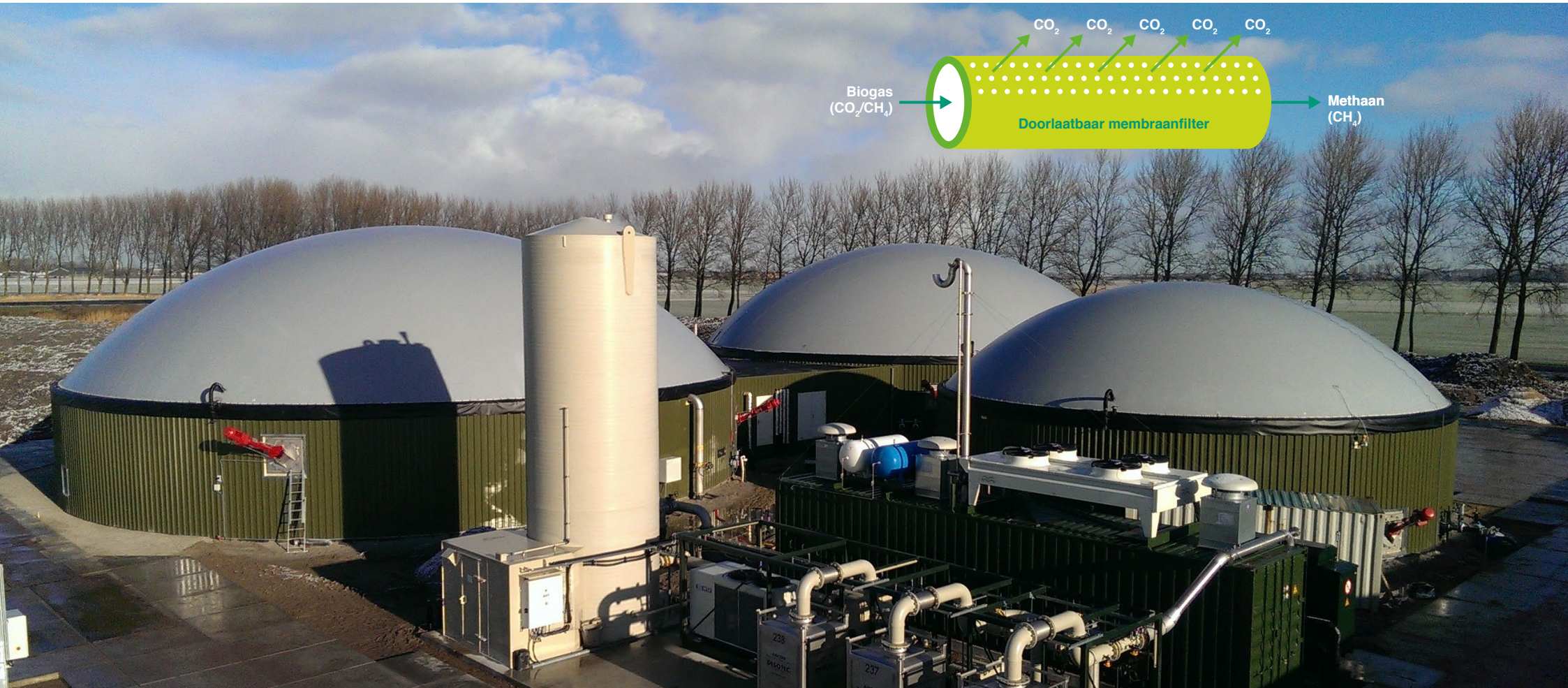
17 Vergister met membraaninstallatie
